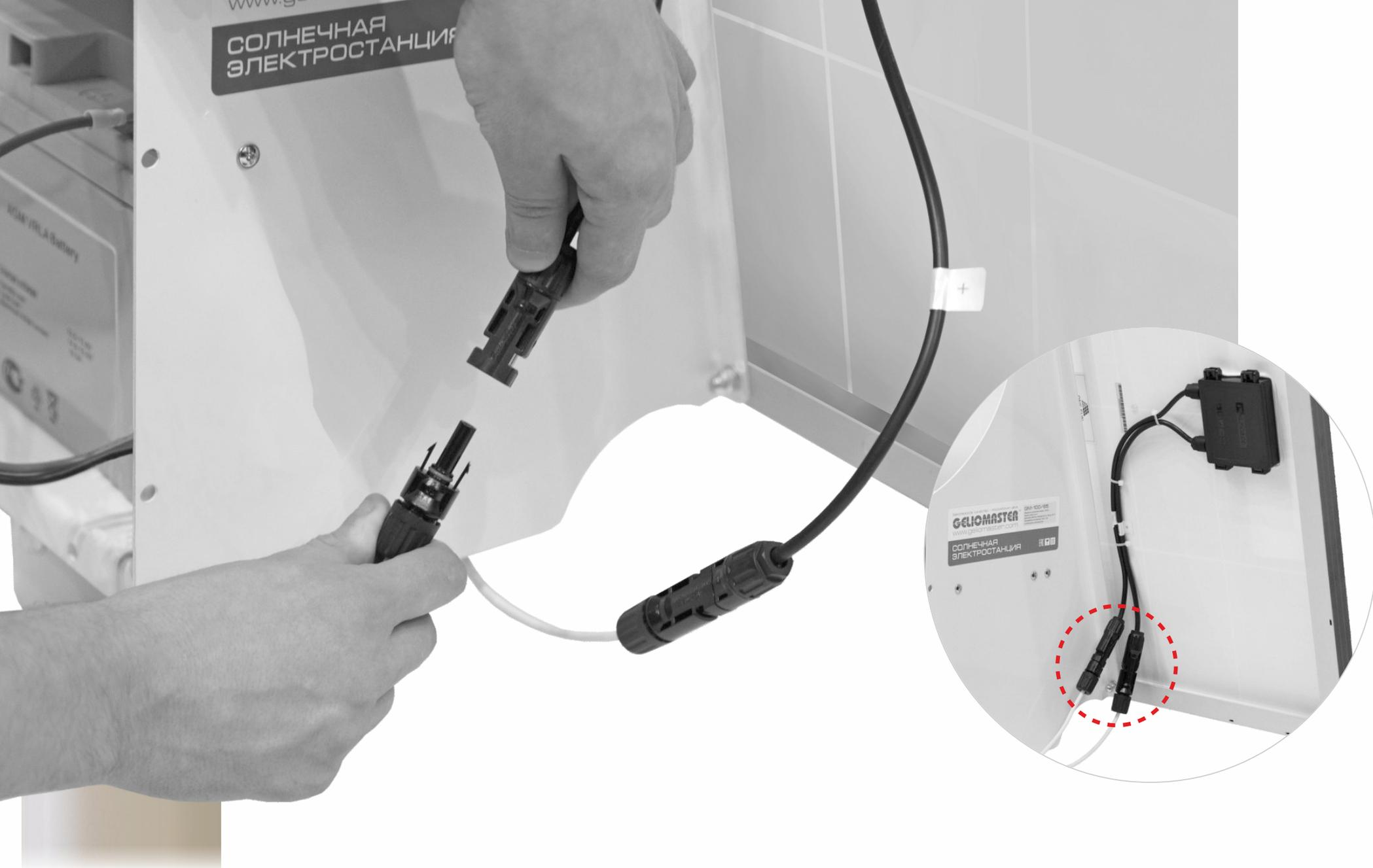
Для активации работы солнечной электростанции подключить кабельный вводы солнечной панели к разъемам соединительного кабеля ящика АКБ.
