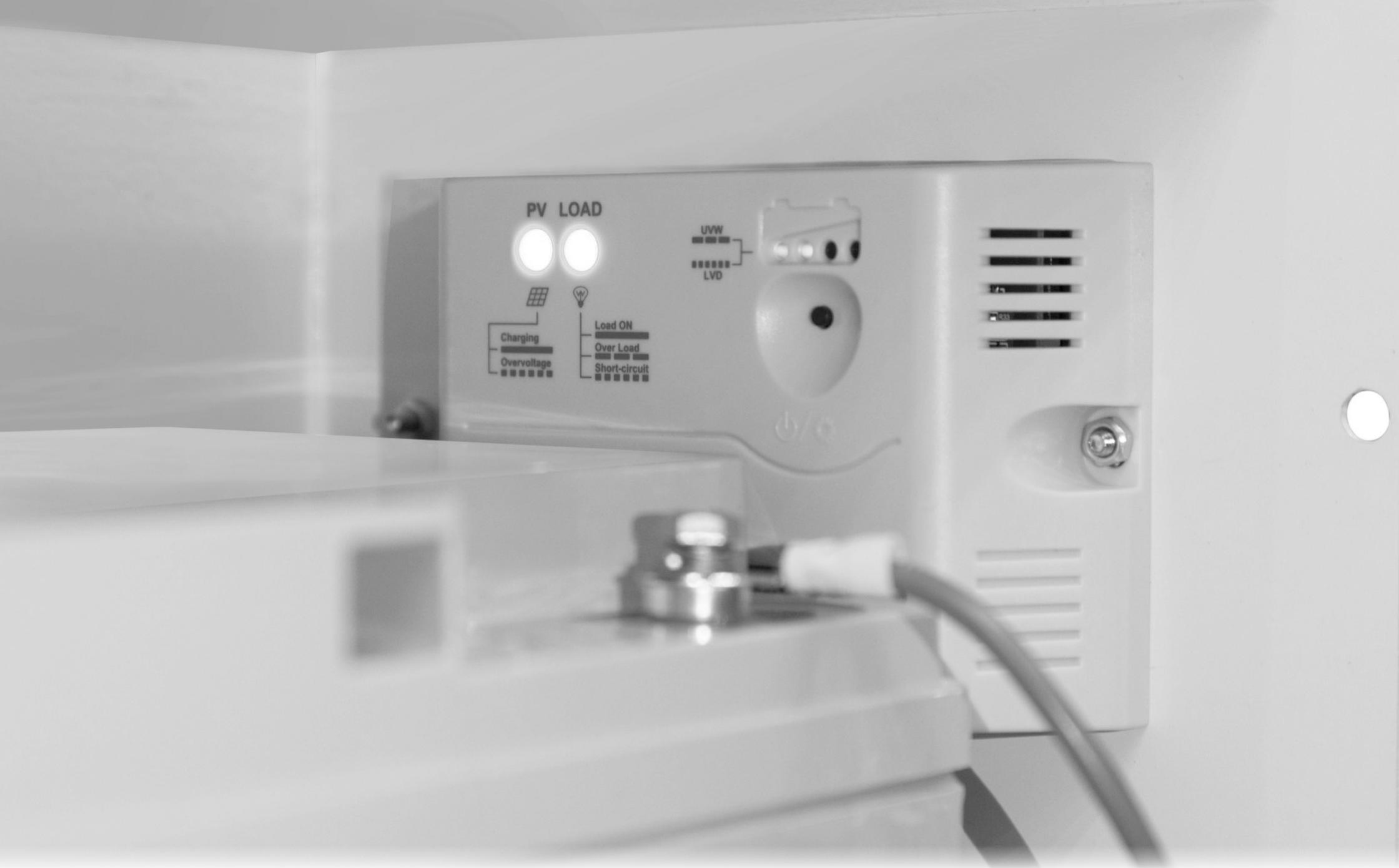
При правильном подключении соединительных кабелей солнечной электростанции с ящиком АКБ, на контроллере загорается зеленый индикатор «PV».
