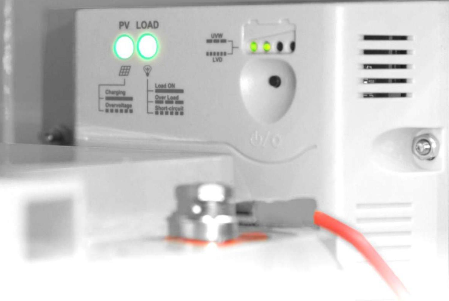
При правильном подключении соединительных кабелей солнечной электростанции с ящиком АКБ, на контроллере загорается зеленый индикатор «PV».
